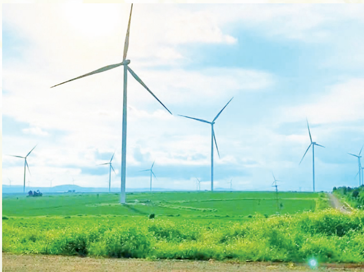
Nhà máy điện gió tại tỉnh Gia Lai. Ảnh TC
