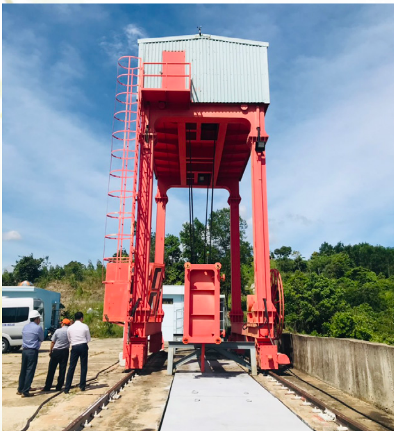
Kiểm tra công tác an toàn đập thủy điện.
