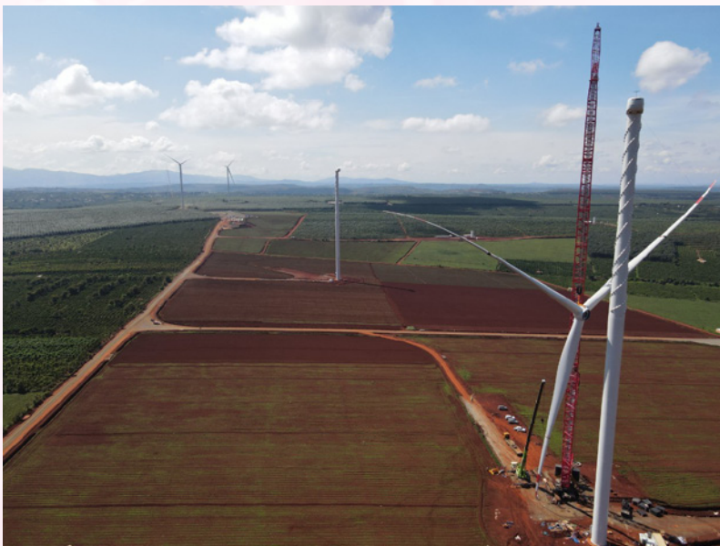
Công trình dự án điện gió tại Gia Lai.
