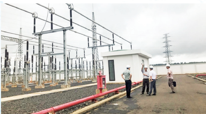
Thanh tra việc chấp hành pháp luật trong lĩnh vực hoạt động điện lực về phát điện. Ảnh Thanh tra
