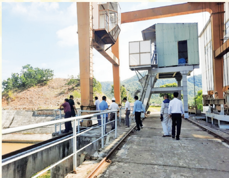
Kiểm tra an toàn công trình thủy điện (Hoàng Hùng).
