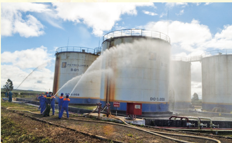
An toàn trong công tác PCCC (Hoàng Hùng).
